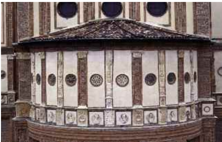
Complesso di Santa Maria delle Grazie - Vista generale esterna a fine lavori
