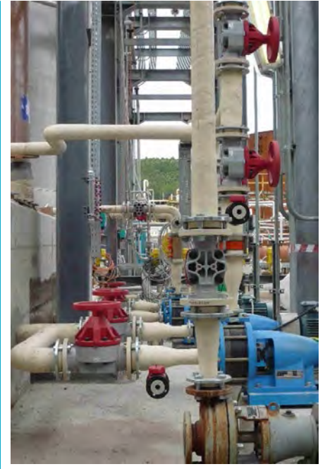
Figura 2- Tipico impianto piping cloro-soda
