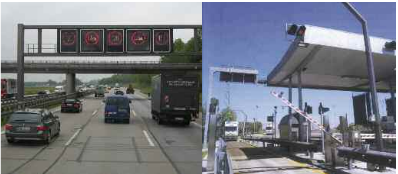
Figura 1. Esempi di sistemi ITS per la rete stradale e il telepedaggio
