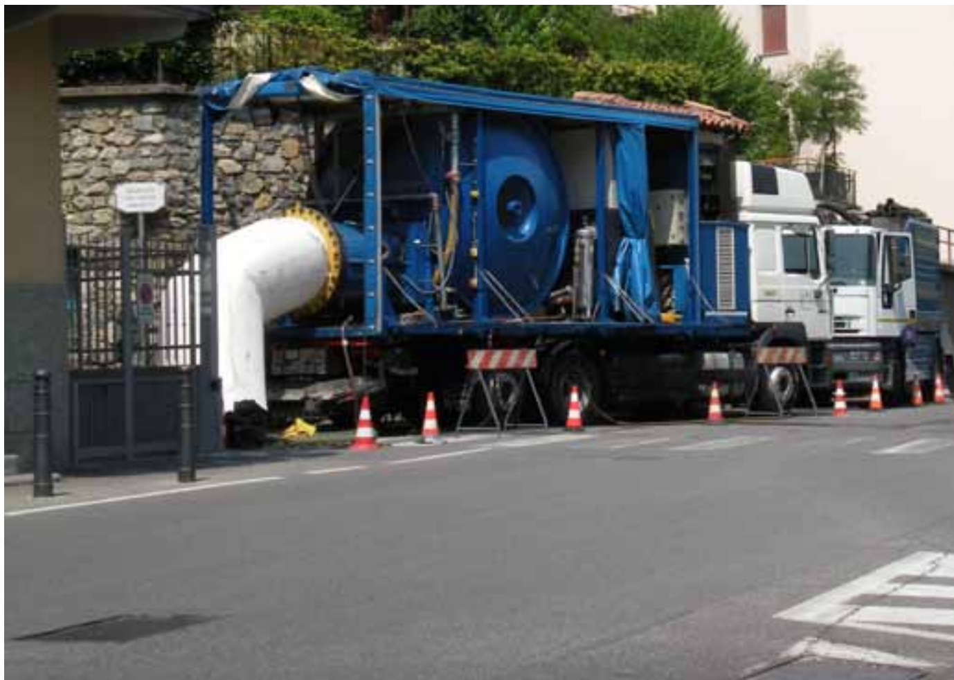
Relining CIPP con posa ad inversione ad aria di un collettore diametro 100 cm direttamente da un chiusino standard.
