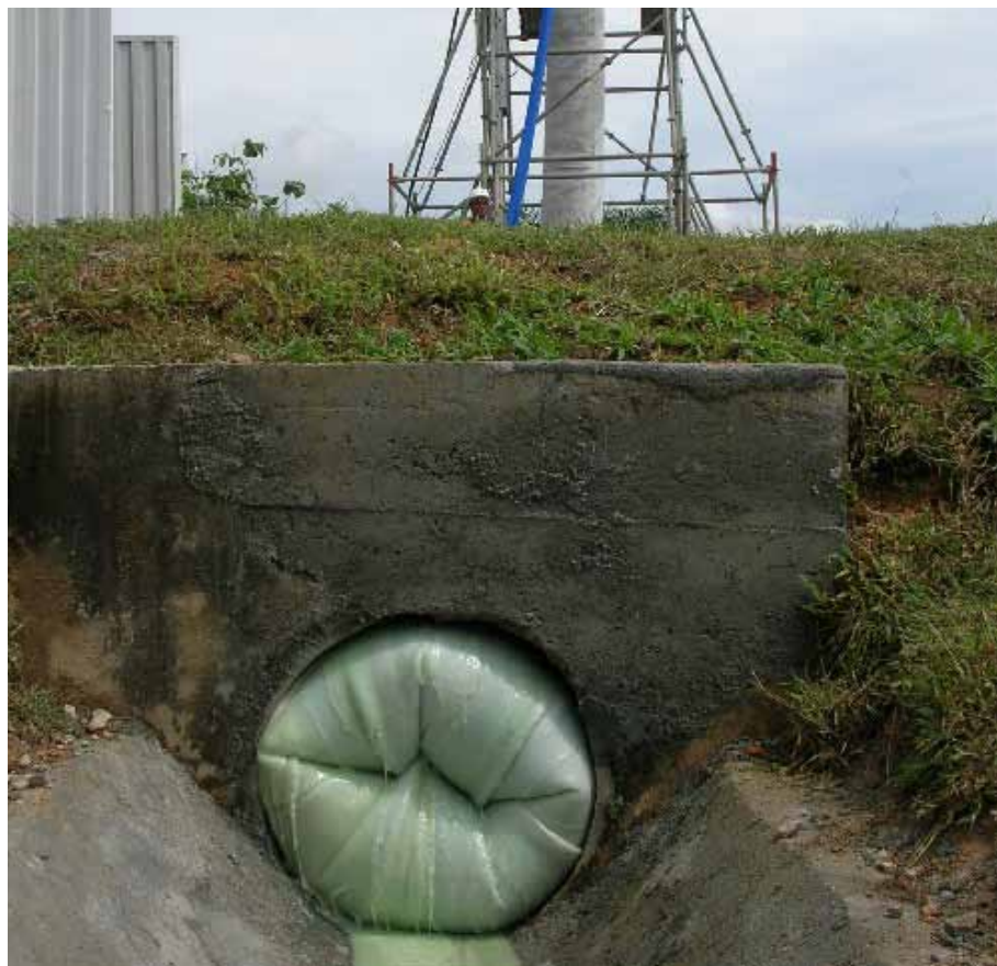
Sullo sfondo la colonna piezometrica di spinta per la posa del tubolare mediante inversione ad acqua; in primo piano il composito in arrivo poco prima dell'avvio del processo di indurimento.
